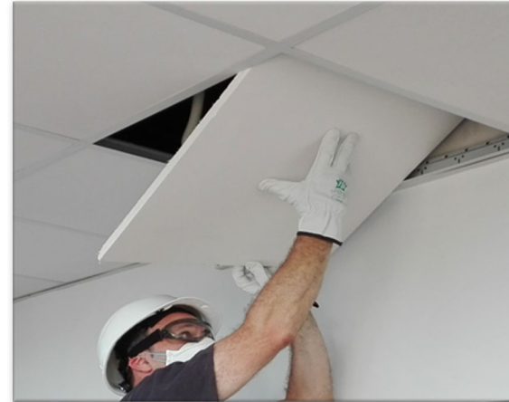
IMAGEN 6. COLOCACIÓN DE LAS PLACAS DE TECHO LIFE-REPOLYUSE
